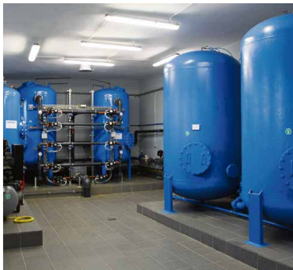
Stacja uzdatniania wody w Sycewicach - przed i po modernizacji.
