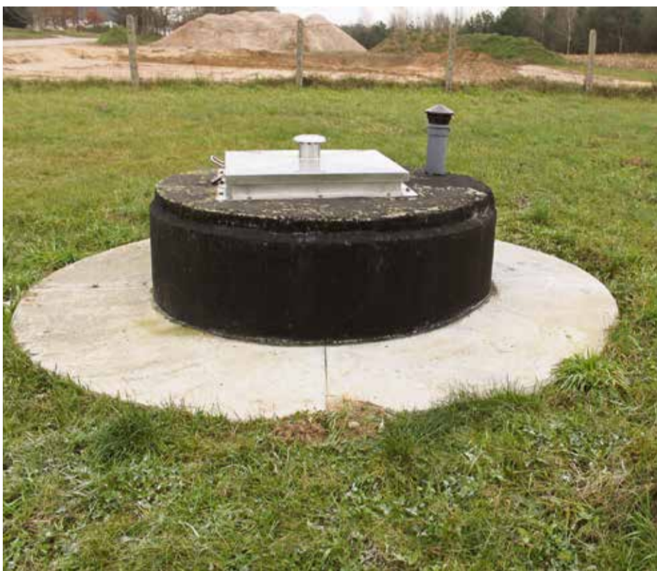
Studnie głębinowe na ujęciu wody w Komilowie - przed i po modernizacji.
