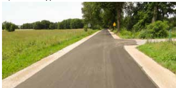
w trakcie realizacji
