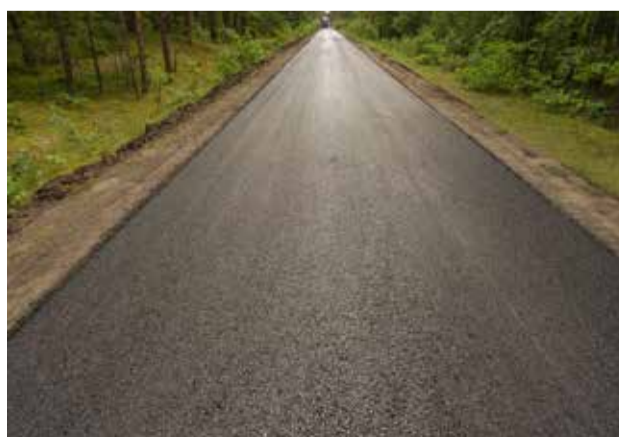
w trakcie realizacji
