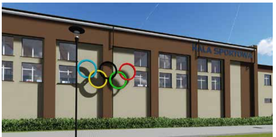
Nowa hala w Kwakowie ma być obiektem nowoczesnym i dobrze wyposażonym
