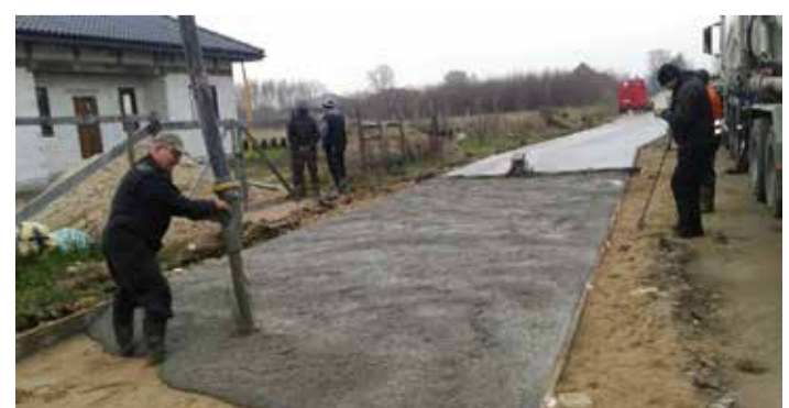
Ulica Jarzębinowa w Łosinie. Jeszcze w czasie prowadzonych prac
