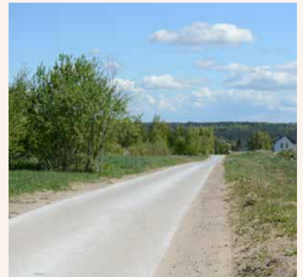
Docelowo ulica Kalinowa będzie stanowiła połączenie od skrzyżowania z ul. Głównej do skrzyżowania z ul. Franciszkańską
