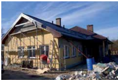
Budowa świetlic w Łosinie i Reblinie 2012 r.
