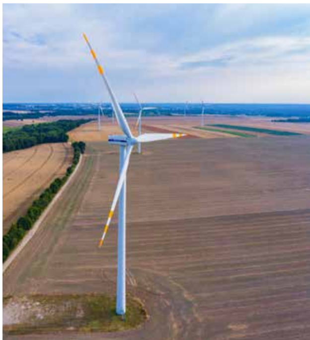
Trybunał Konstytucyjny dał 18 miesięcy na zmianę przepisów związanych z opodatkowaniem wiatraków, aby stały się zgodne z Konstytucją. Sprawa dotyczy między innymi farm z okolic Łosina
